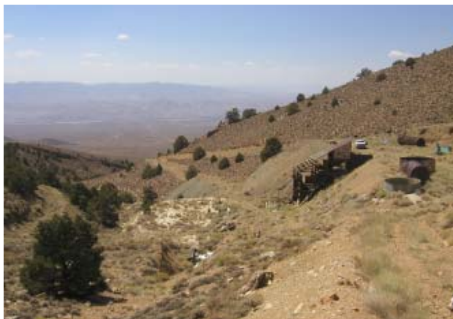
Una mina de oro abandonada en Nevada. Obsérvese los restos de la estructura usada para la molienda del mineral. También se ven los tanques de almacenamiento del barro de mineral de hierro. Más abajo se ve la laguna de almacenamiento de las colas del material
